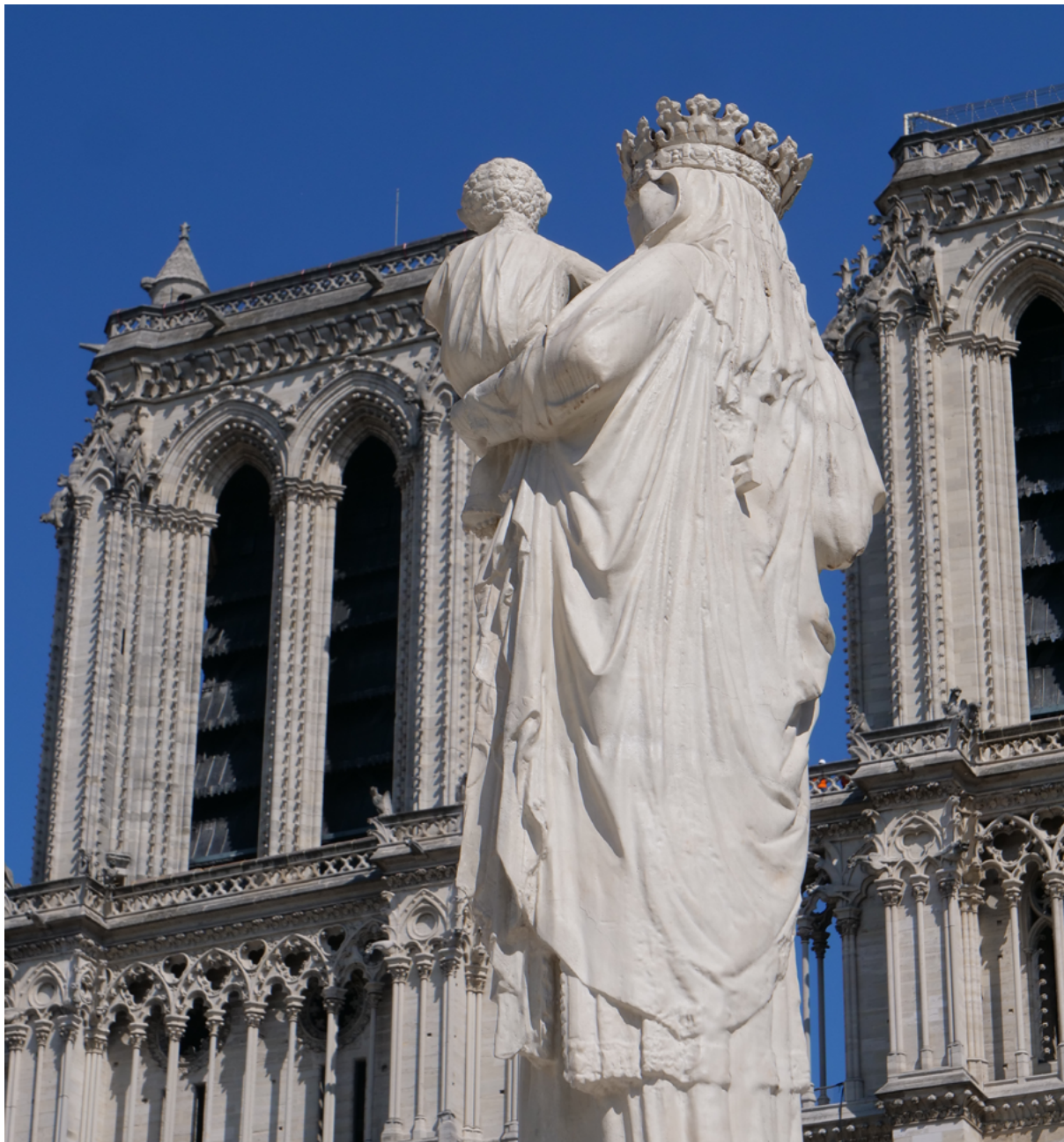
DÉTAIL DE LA FAÇADE ET RÉPLIQUE DE LA STATUE DE NOTRE DAME DE PARIS INSTALLÉE SUR LE PARVIS PENDANT LA DURÉE DES TRAVAUX
